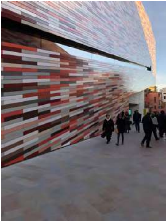
B Lo spazio diagonale tra gli edifici
