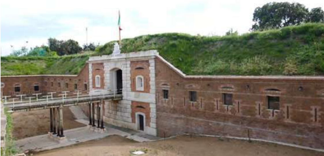
Forte Aurelia, Fronte di Gola: ponte d'ingresso al forte (foto F. Meneghelli).
