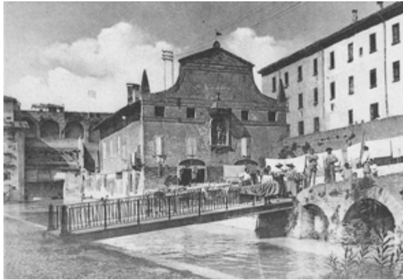
Fig.2 Cavaticcio con il ponticello e, dietro, l'edificio con la Dogana del Porto
