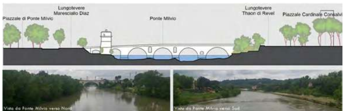
Stato delle sponde a monte e a valle di Ponte Milvio, dove il fiume appare come una infrastruttura verde parzialmente antropizzata
