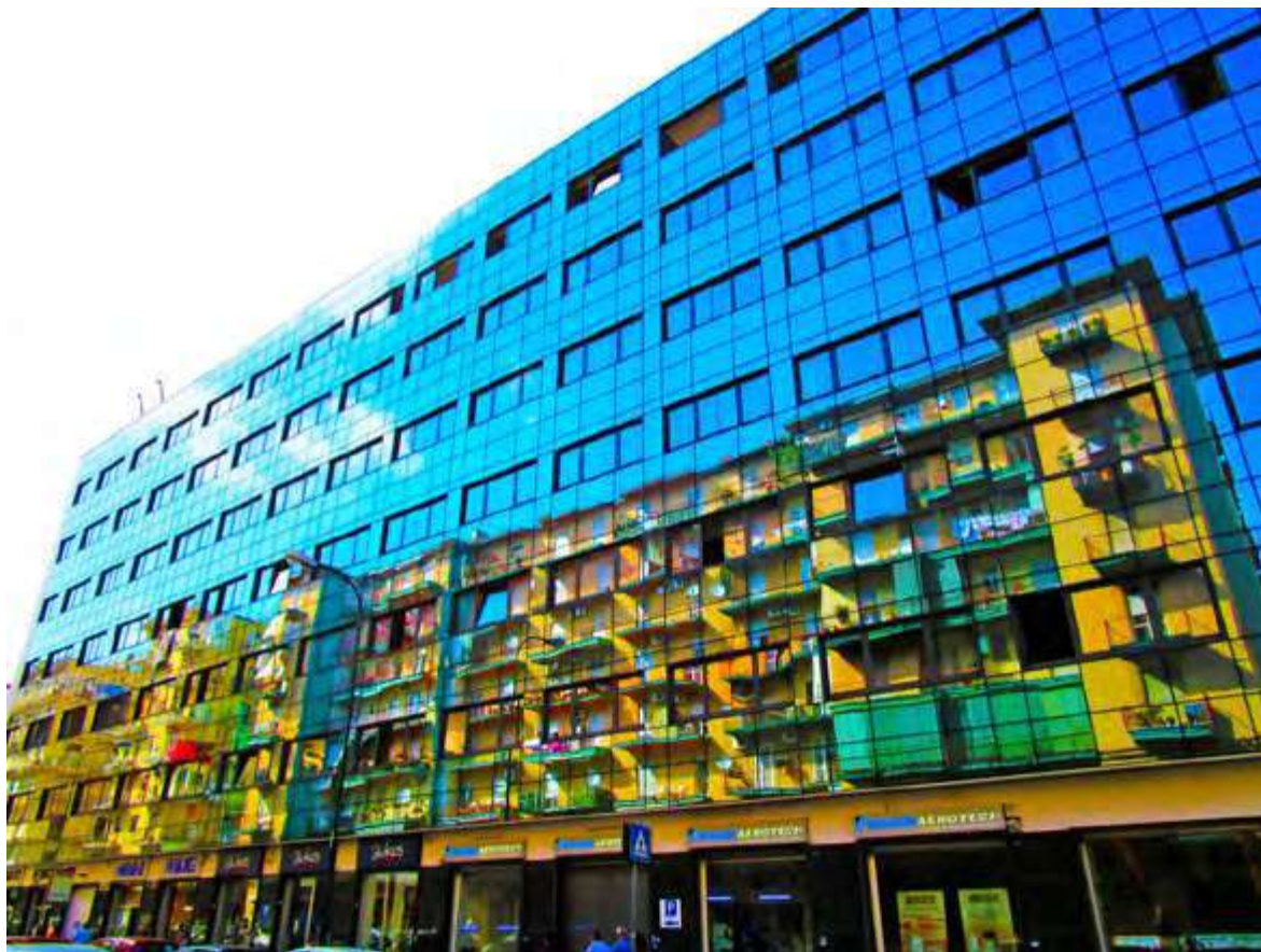
Figura 4. Napoli, 2015, il vecchio edificio si specchia nel nuovo edificio.
