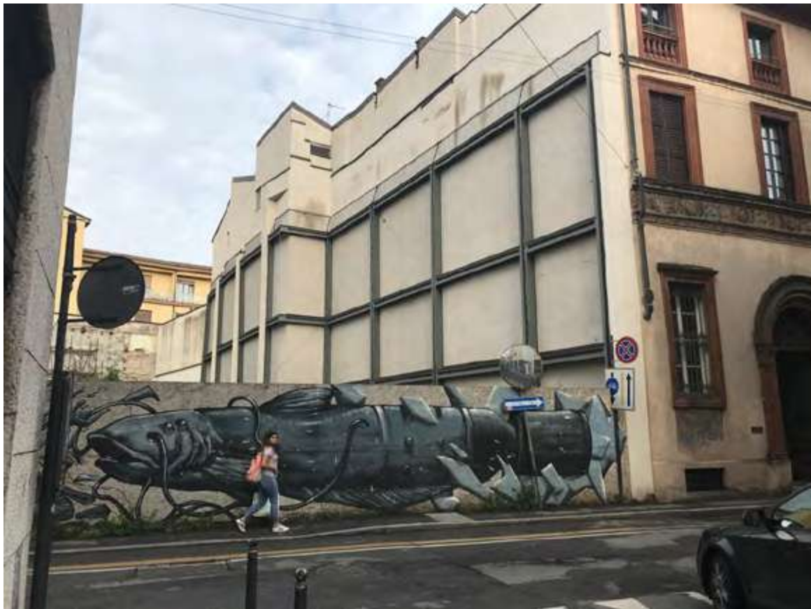
Illustrazione 3. A destra il Palazzo Ugolani Aschieri con in evidenza il rafforzamento di protezione strutturale per ridurre anche i rischi sismici, e a sinistra l'area ove sorgeva l'ingresso del Supercinema.
