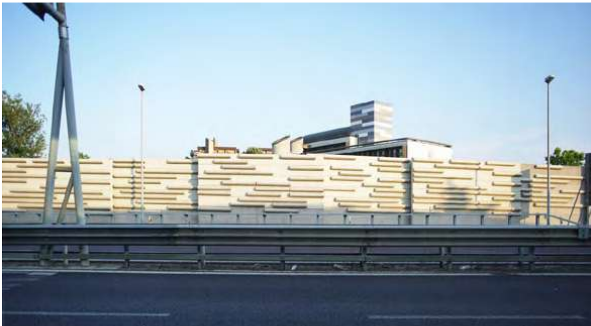
Fig.6 Worklife Innovation Hub tangente allo snodo autostradale di Casalecchio di Reno, incubatore d'impresa e di start-up.
