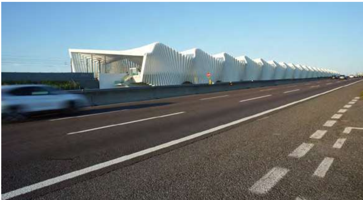
Fig.5 Stazione A.V. Mediopadana di S.Calatrava a Reggio Emilia, accostata al tracciato allargato dell'Autostrada del Sole.
