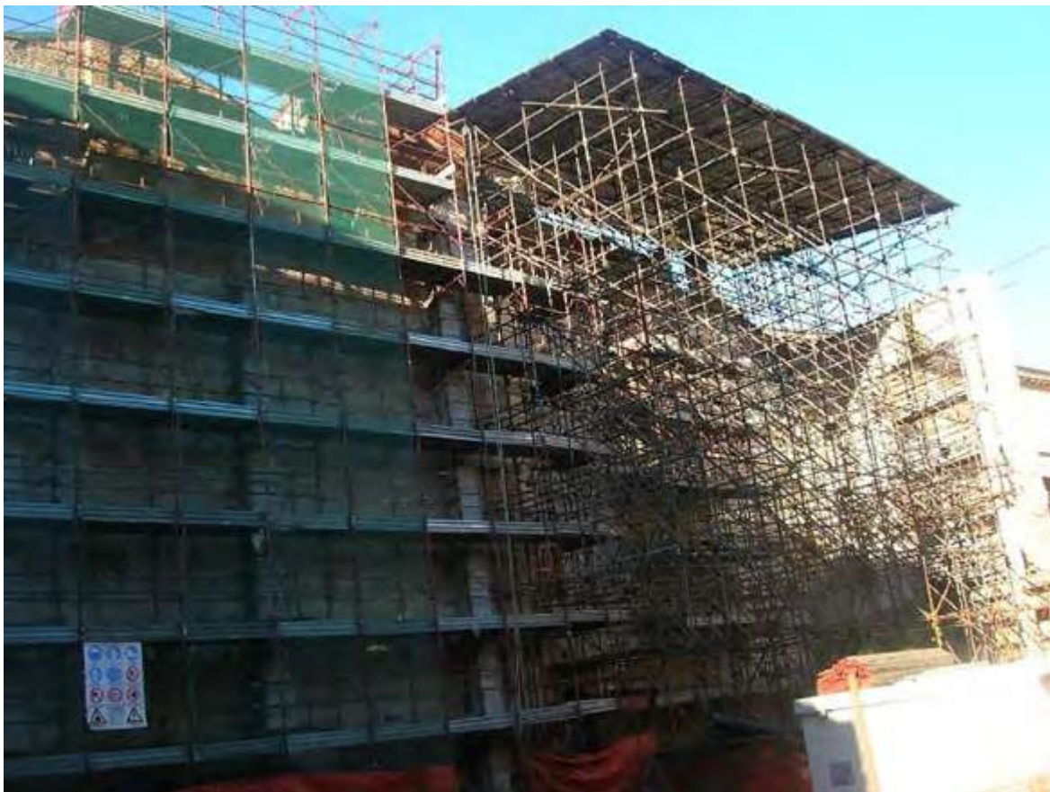
Illustrazione 2. Il cantiere una volta sospesi i lavori a causa dei cedimenti della struttura di Palazzo Ugolani Aschieri.
